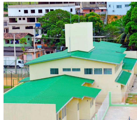
VIANA: Construção da UPA 24 horas e várias obras
