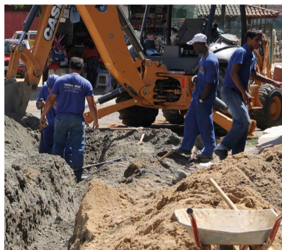
NOVA VENÉCIA: importantes obras de infraestrutura
