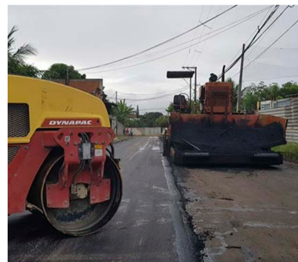
SERRA: Obras de drenagem e pavimentação em Balneário Carapebus
